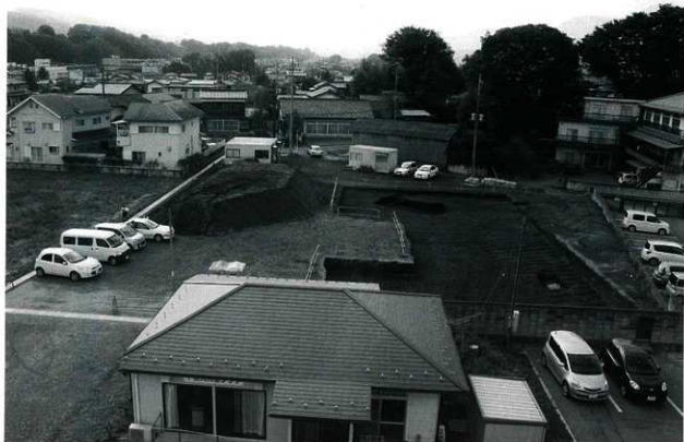
遺跡遠景(南東から)
