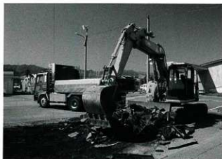
重機によるアスファルト除去作業
