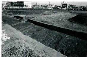
66号溝完掘状況(南西→)
