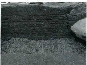
SB - 1 構築状況 (3)
