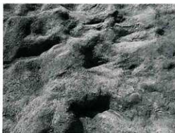
地業底面ハードルーム層の状況
