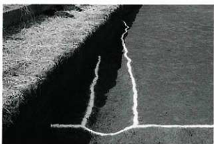
2号溝 完掘状況(南から)
