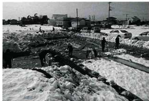
除雪作業風景（北東から）
