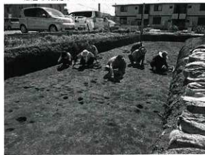
A&B 除去作業 (北から)
