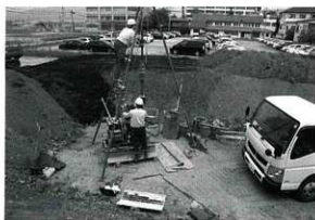
ボーリング調査風景（南から）
