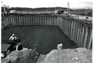
5号溝 転圧作業風景（東から）
