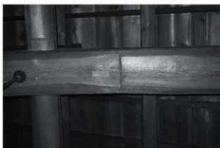
・「を-14」の柱ホゾ穴と圧痕（写真ほぼ中央） : 左右に架かる下梁が「14」通り。柱当りを水平に決り、圧痕は色変わり。
