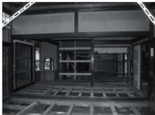
・「離れ」1階座敷背面：座敷背面に上段と床の間 座敷、上段共に室の左端の根太方向が異なる。 上段左側面の黒枠は押入。耐震壁に変更。
