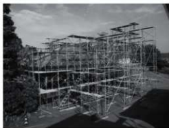
・素屋根：素屋根の軸組は足場利用
