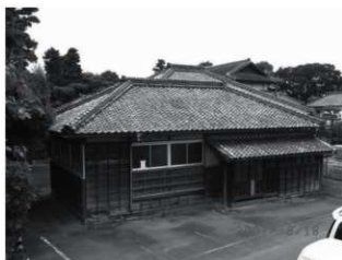
作業棟：工事前の作業棟右側面（修理前） 後方は主屋棟屋根及び「離れ」棟
