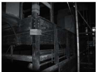
・柱「て-26」の1、2階の繋ぎ：下側の柱は平角材=軒桁の下で切れ、2階の柱の半分であろう部分が、その柱に乗る。一方、軒桁は2階柱の最下部を欠き込んで密着されている。上側の2方向の平角材は2階柱に留まる。この側面にL型金属板がボルト止めで施され、縦横4材を固定する。
