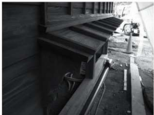
・復原した台所左側面地窓：持ち送りと板屋根。
