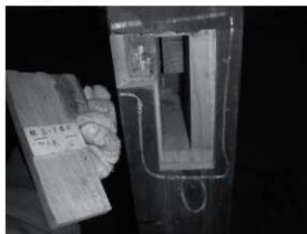
・柱「を-9」の窓敷居の痕跡 : 同柱の既存上框の上方に窓敷居の大入れホゾ穴の痕跡。変更時期を決定する資料は見出してない。上框の天端は「13通り」の上框と同等。
