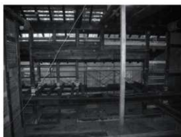
・写真中央挿鴨居後補: 撤去 柱の横から取り付けが見える。
