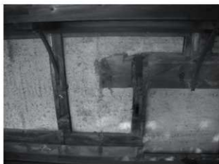
・「離れ」棟左側面中央：1階と2階の間に旧軒桁が残存し、旧背面側の軒桁掛鼻の痕跡が見える。
