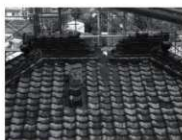
・解体工事前の調査
