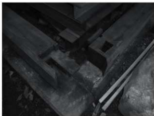
・作業場棟「いー1」土台隅
