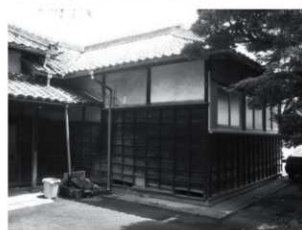
・作業場棟左側面及び正面： 左端は主屋棟右側の出入口引き戸。 正面の高窓はアルミサッシュ。
