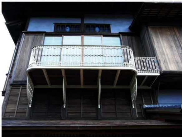
「離れ」正面 2階部分
