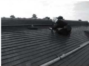
・「離れ」2階屋根：銅板平葺きを桧皮に似せる 銅板平葺き施工の最後行程。桧皮葺きに似せる 為に、銅板重ね部分を若干、鉋で浮かせる工法 を採用した。木棒は足場材。
