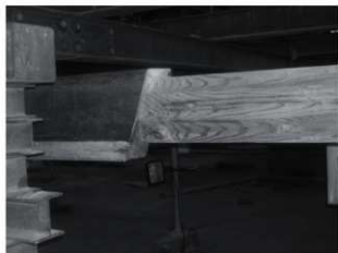
・蟻害を受けた台所・ひろま境板間上框の修理2 被害箇所が確定後、補修方法を検討。その方法に合わせて元材を成型する。
