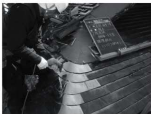
・「離れ」2階屋根隅棟： 旧桧皮葺屋根を模倣して銅板平葺き施工。 隅棟は桧皮葺きに似せた丸みを付けた蛸型。
