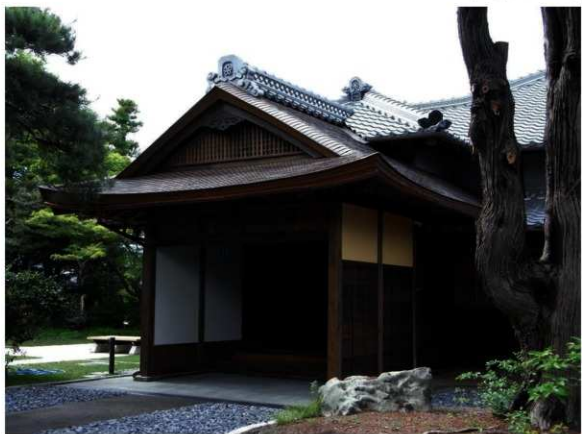
式台玄関 主屋左側
