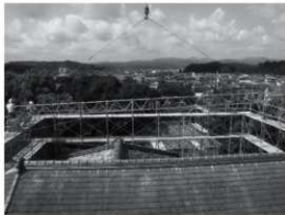
・素屋根大梁の施工
