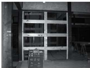
・柱「ね-18」と柱「ね-20」：左下の写真の工事中的の状態。耐震壁にする為に貫間隔が既存貫穴と異なる為、辺付を用いて固定する。壁中央の柱「ね-19」は「19」通りの耐震壁を受ける為、半柱を正角柱に変更した。
