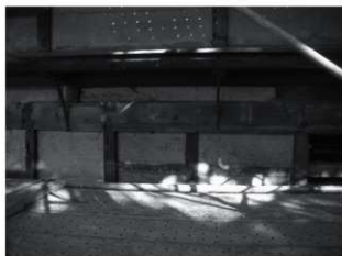
・上記写真の右側部分：1階の柱は既存の状態。旧軒桁の上に2階床を受ける胴挿が2段見える。
