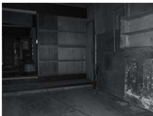
・旧内玄関土間に増設された浴室等 ：鉄板や合板で構成されている。
