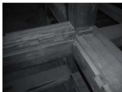
・柱に挿し込まれた足固
