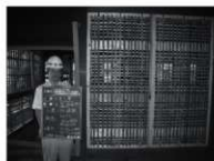
・壁下地の検査：市の立会い検査
