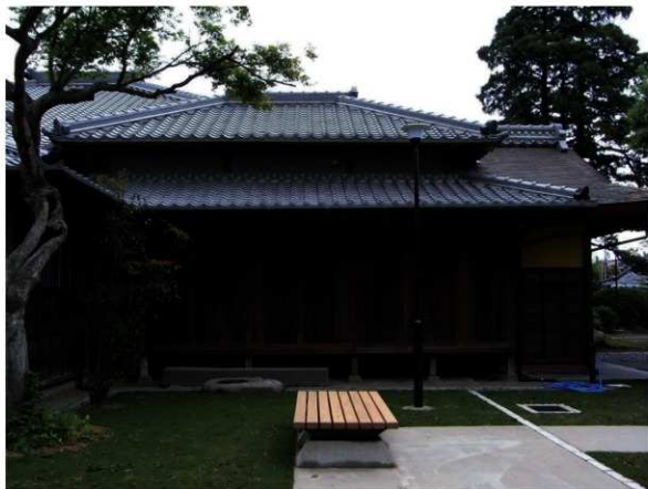
主屋左側面（正面側）と便所棟、式台玄関
