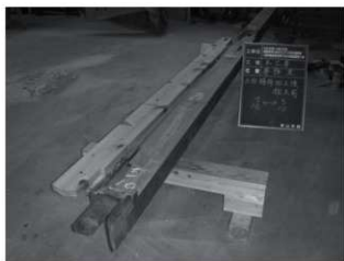
・土台の修理：腐朽部分を取り除き、新材で補修
