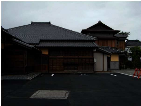
主屋左側面と作業棟背面
