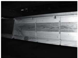
・蟻害を受けた台所・ひろま境板間上框の修理3 成型した元材に補充材を取り付ける。工法を決定する。極力、接着剤の使用を避け、極力、木目を元材に合わせて、木材の経年変化の歪を避ける工法を探し出す。
