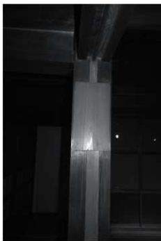
・柱「よー12」の挿鴨居の痕跡
