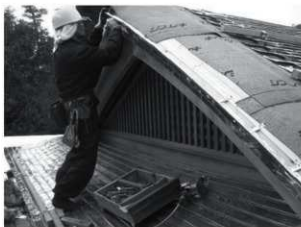
・復原式台玄関屋根葺き甲：銅板平葺き施工 銅板は厚さ 0.4 mm。
