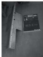
・「離れ」て-26柱 上下柱と胴挿を ST 板で補強
