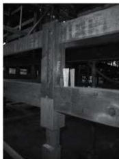
・腰壁東「へー16」の補修： 足固はボソ挿し十車知栓留。
