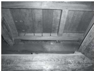
・上記写真の小屋梁上の床小梁と根太：2階洋間 の床板=檜材は根太に手違い釘で固定。
