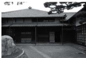
竣工時の正面外観
