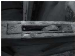
・鉄製戸車: 近世型であるが、木ビスが近代を示す。
