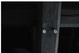
「た-14」の柱ホゾ穴と圧紺 : 母子の付く小屋梁が「14」通り
