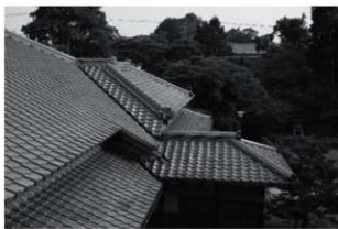
・背面側から見た主屋左側面屋
