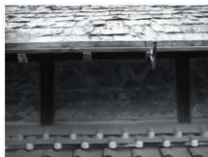
・上屋軒下と下屋屋根根間の小壁に黒色が見える。（解体中）
