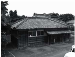
・作業場棟右側面： 中央窓はアルミサッシュ、中央出入口は木製 硝子戸がパテ止めではないので後補であろう。
