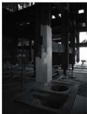
・作業場棟右側柱根継ぎ：金輪継ぎ 写真下方の穴等は土間の便所痕跡。
