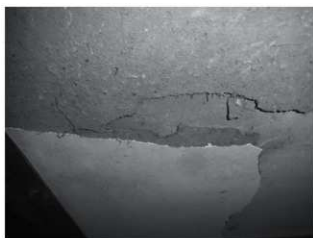
・土塗り壁剥離調査: 塗り重ねを薄い箇で剥 ぎ取り、塗り重ね工法と塗厚、土質を調査。
