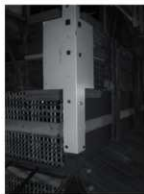
・「離れ」て-26柱 上下柱と胴挿を ST 板で補強
