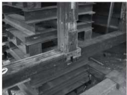
・土台、足固、貫：壁の部分にも足固を施工。柱のやや上の大入・ホゾ穴は足固用、その直上に貫の穴が見える。
