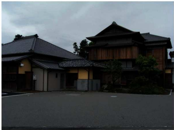
主屋棟と「離れ」右側面
