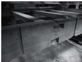
・「5」通りの旧上框下地（上写真は全体、中央の横材が上框、下写真がその部分詳細）
