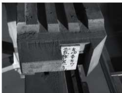
・「ちー7~10」の出入口敷居: 溝が深く、極端に金属板止めの釘穴。端の極端に金属板決りが付く。相方土台の当りと溝の塵出し欠きも施される。
