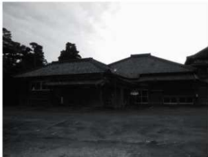
・作業場棟及び主屋棟右側面： 作業場棟の窓と主屋棟の窓は共にアルミサッ シュが施されている。
