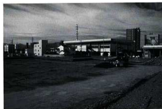
重機による埋め立て作業風景（北東）
