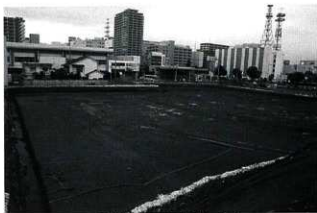
1区完掘①（南東から）
