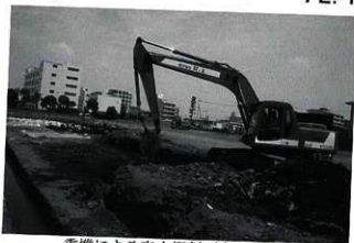
重機による表土掘削（南西から）
