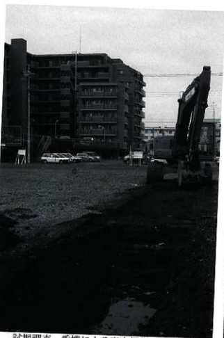
試掘調査 重機による表土掘削（北から）
