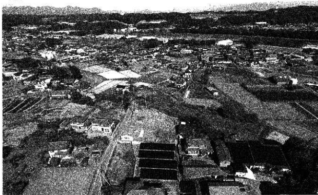
SB03 遠景 南から
