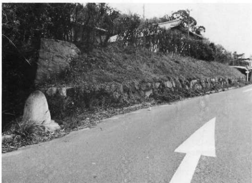
(2)御台場の石垣(西方より、手前の石は柳水の碑)
