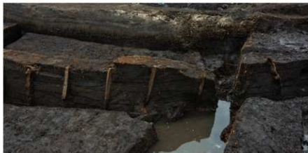
3 杭打設状況③ (杭 15～20)
