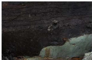
2 開削部土層②(階段状の切土)
