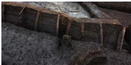
2 杭打設状況② (杭 5～13)
