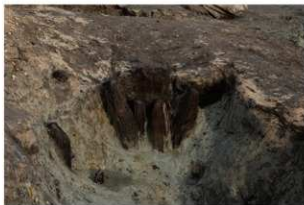
1 第5号木組遺構木組部東辺杭打設状況
