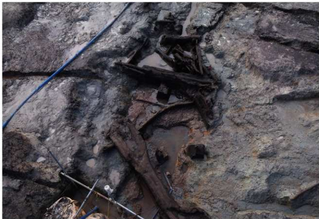
5 開削部の状況 (北東から)
