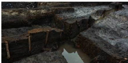
4 杭打設状況④ (杭 16～24)
