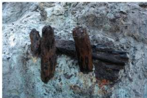
3 第3号木組遺構東辺杭打設状況
