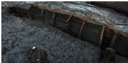
1 杭打設状況① (杭 1～9)
