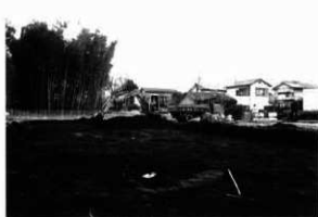
2. 表土剥ぎ風景
