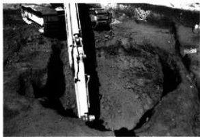
2. 145号土坑 重機による発掘風景
