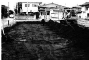
3. 表土剥ぎ風景
