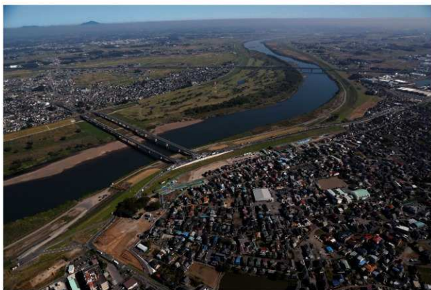
2 栗橋宿跡第8地点遠景（西から）
