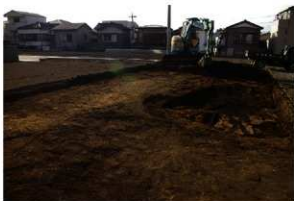
2. 表土剥ぎ風景
