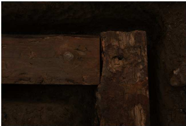
1 第1号建物跡北西隅基礎
