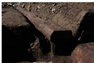
4 第2号建物跡基礎(3) 東から
