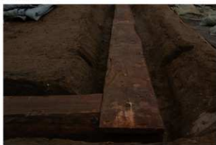
3 第1号建物跡南辺基礎（2）西から
