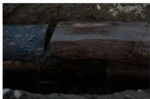
7 第2号建物跡基礎(6) 南から
