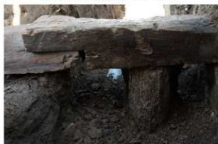
8 第2号建物跡基礎(7) 南から
