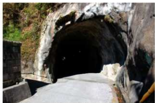
【木出】逢島隧道
