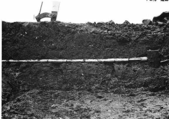
(1) 15トレンチ上水道施設 検出状況 (南から)
