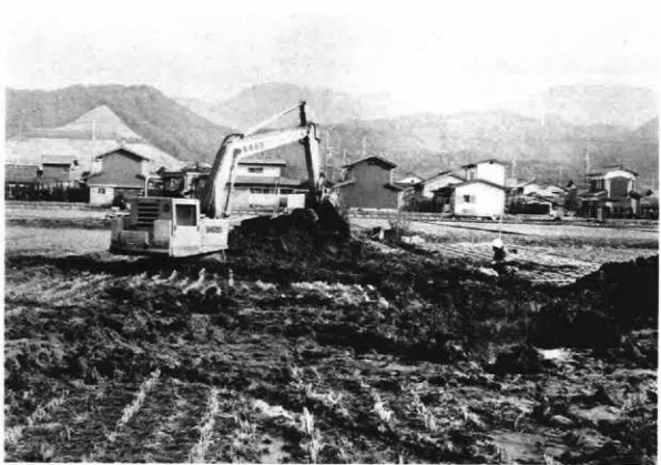
(2) 試掘調査状況
