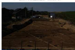
8 宮東5次調査区全景（東側から）
