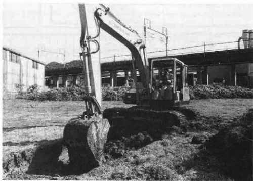
写真1 重機による表土掘削
