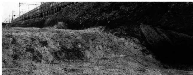
堰の肩 (南東から)
