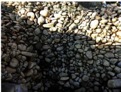
第136図 良好な裏込め 小峰城跡藤門
