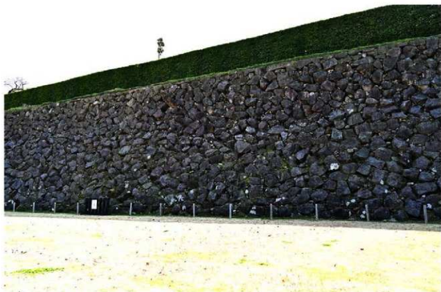
3. 3440N 中央部（北から）
