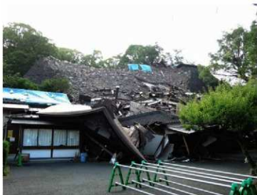
第 137 図 熊本城跡東十八間櫓台の崩壊
