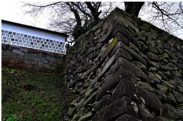
7. 3440E (北東から)
