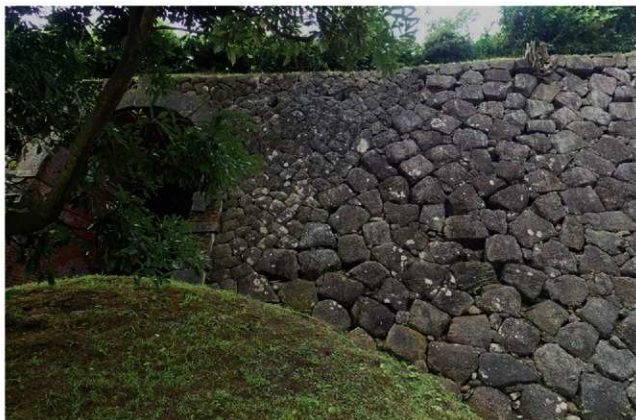
4. 1301N 弾薬庫 (北から)
