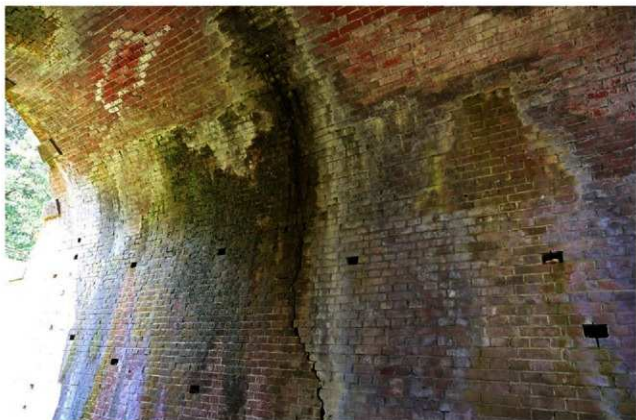
10. トンネル内のレンガ積（北から）
