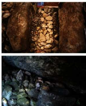
第134図 石垣内部の施工状況 (上: 変積, 下: 薪ノ丸北)
