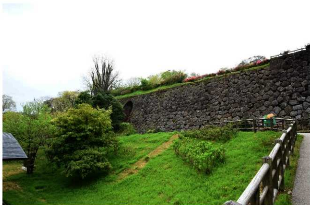
3. 1301N (北西から)
