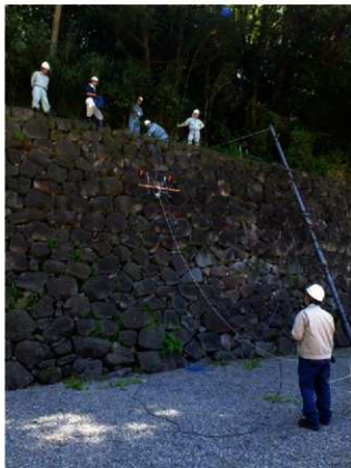
第 83 図 電磁探査作業風景
