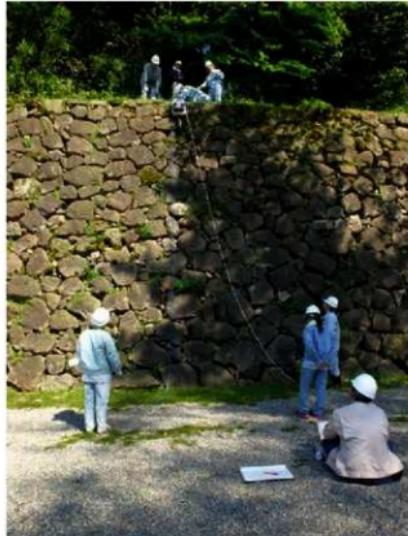
第 82 図 GPR 探査作業風景
