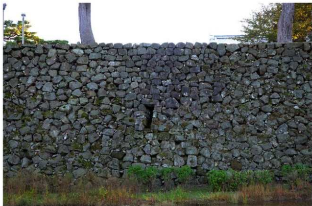
7. 3500N 吐水口周辺 (北から)
