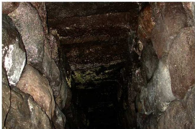
10. 3500N 石積暗渠の天井部（北から）
