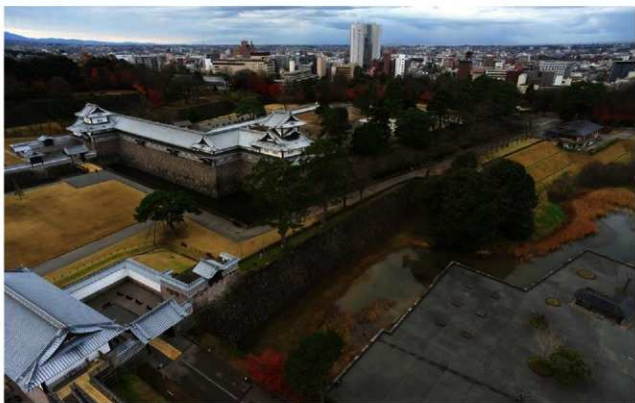
1. 3500N 全景 (北東から)
