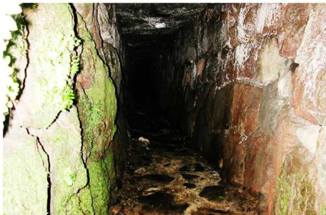
9. 3500N 吐水口奥の石積暗渠（2002年撮影）（北から）
