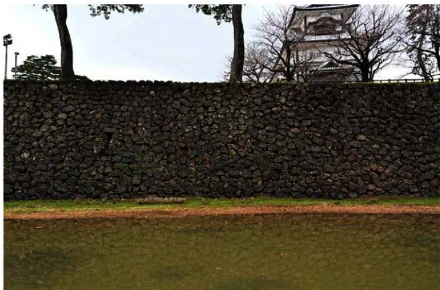
4.3500N 中央部（北から）
