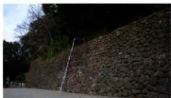
No.1・2(6501W, 6500W 数寄屋屋敷西堀縁)
