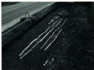
As-A砒石充填道構 輸出状況（南東より）
