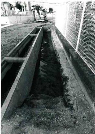
A区第3面東半完掘状況全景(東→)
