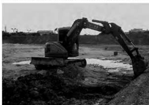
図版21 表土剥ぎ作業と樹木の移植作業
