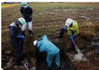
1 トレンチ 調査風景（北東から）
