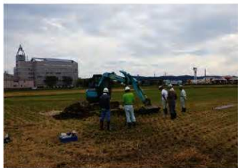
5 トレンチ 調査風景（北から）
