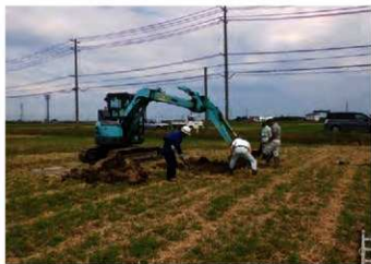
8 トレンチ 調査風景（南西から）
