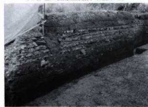
▲ 7. 調査区西壁 (南東から)
