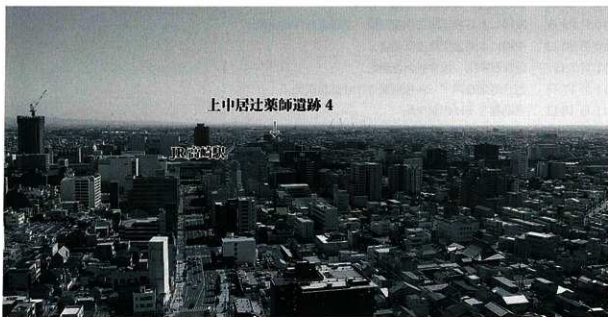
高崎市役所からの遠景（東を望む）
