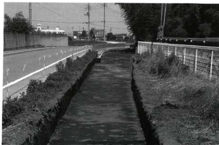
A区全景 西から
