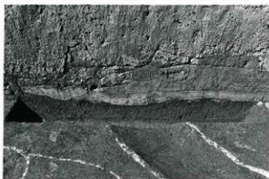
SD-2 Cセクション 東から
