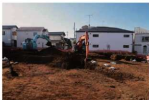
4. 調査区西部表土剥ぎ（東から）
