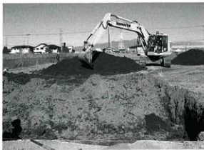
調査区盛土掘削 2
