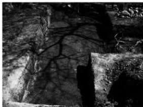
写真82 T12遺構養生状況（西から）
