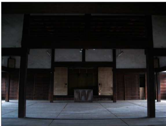
14 彦根市中央町 講堂遺構内部状況（彦根市指定文化財）
