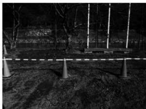
写真84 T12埋戻し完了状況（西から）
