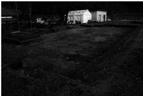
写真50 T10講堂跡遺構検出全景（南西から）
