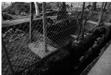
写真72 T12南東隅検出状況（南東から）
