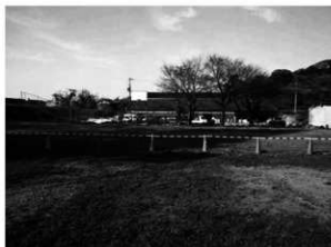
写真65 T10埋戻し完了状況（南から）
