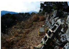
西出丸南端の犬走り 東から
