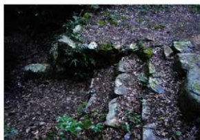
雌池石組護岸と階段 北東から
