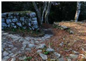
本丸外曲輪北の食い違い虎口 南東から
