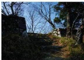
西出丸虎口 南東から
