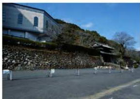
三の丸石垣全景 南から
