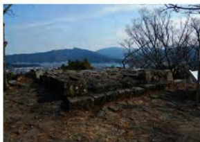
本丸外曲輪二重櫓跡 北西から
