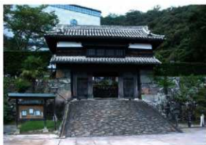
三の丸櫓門 南東から
