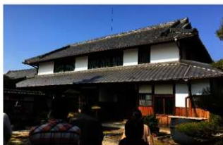
主屋前にある大釜を利用した天水受け
