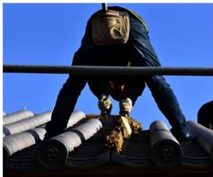
美装化工事 本瓦屋根補修工事
