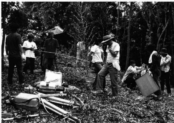
伐採後の測量開始状況
