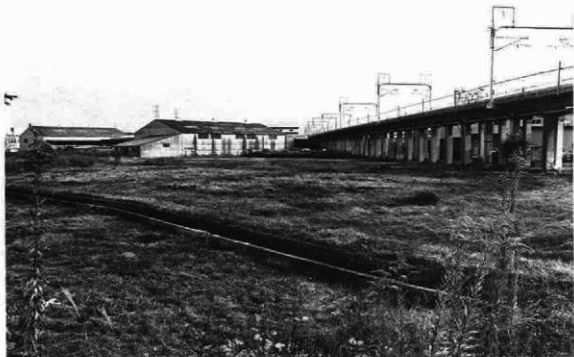
調査前状況（北半部 南より）
