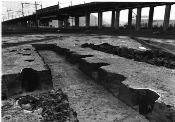
SB02断面割り調査状況
