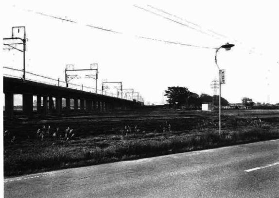
調査前状況（南半部 北より）
