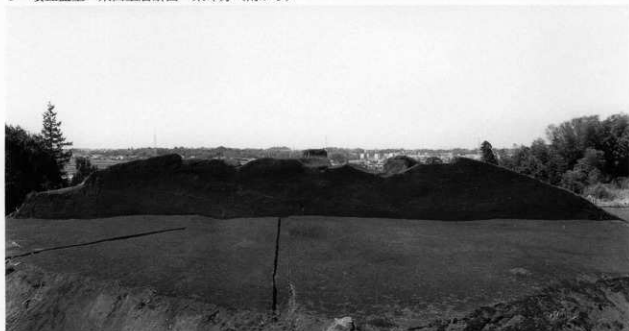
2 墳丘盛土 南北土層断面（東から）
