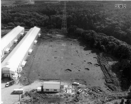
調査区全景(1) (北西上空より)
