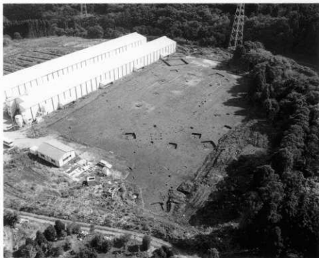
調査区全景(2) (南西上空より)
