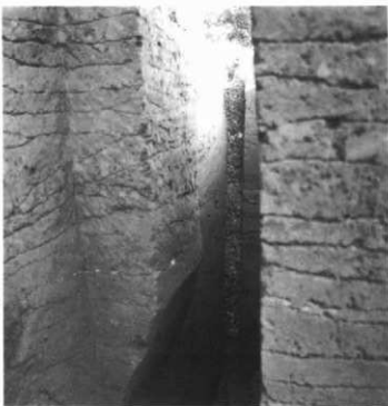
Fig. 16 上福田13号墳 石室後方裏込め土層断面（北から）
