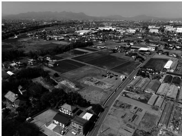
調査地点遠景 南東から
