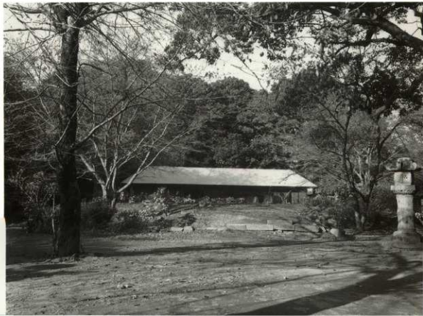
金堂基壇（南より）
