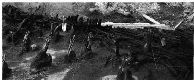
左岸部分の状況：上流からみる
