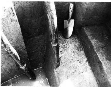
粘土層深く打ち込まれたえぐり込みのある丸杭
