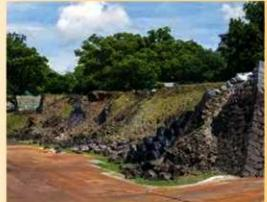
西出丸北側石垣の崩落状況(北西から)
